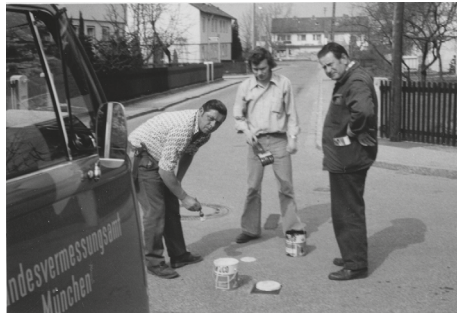
Mitarbeiter beim Aufmalen von Signalisierungspunkten © BVV
